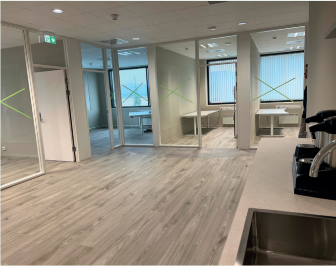
Mellom kontorene er det stedbygde gipsvegger, for minst mulig lyd-gjennomføring. Foto: Inger Anita Merkesdal
