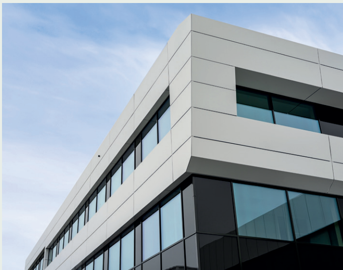
Kontorbygget er reist i betongelementer, men fasaden er oppgradert med aluminiumskomposittplater og glass. Foto: Stian Dirdal
