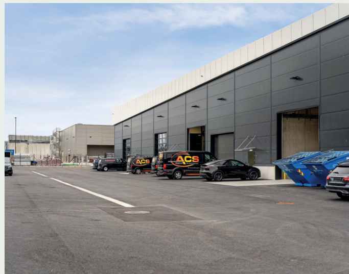
Hallen er reist i stål og sandwichelementer.
